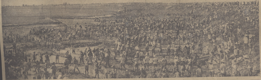
天津市的防汛抗洪大军斗志昂扬，昼夜奋战，加固、加宽堤防，向高水位展开持久战。 国汉摄影
