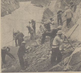
刘家峡水利枢纽工程动工了。
